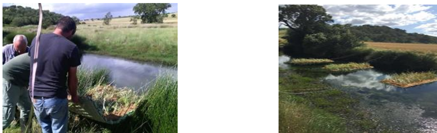
Figura 6. Colocação dos leitos flutuantes na ribeira de Água Forte.
